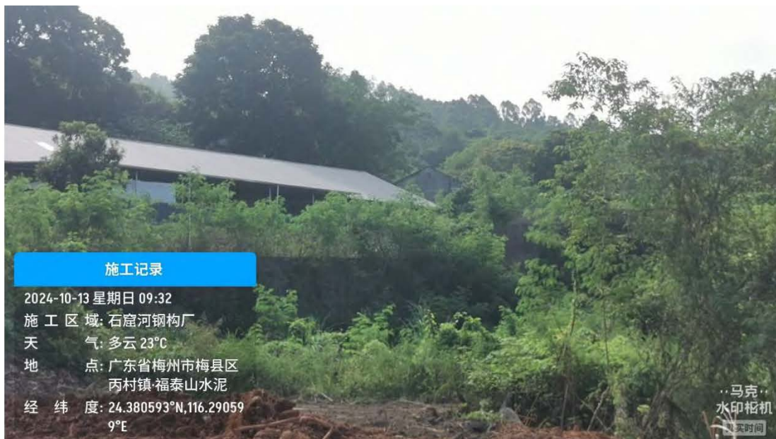
图 3-3 临时用地实地照片（石窟河钢筋加工厂）
