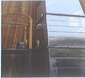
喷漆车间废气排放口
