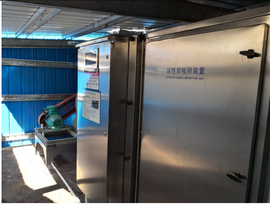
图 3-2 有机废气处理设施
