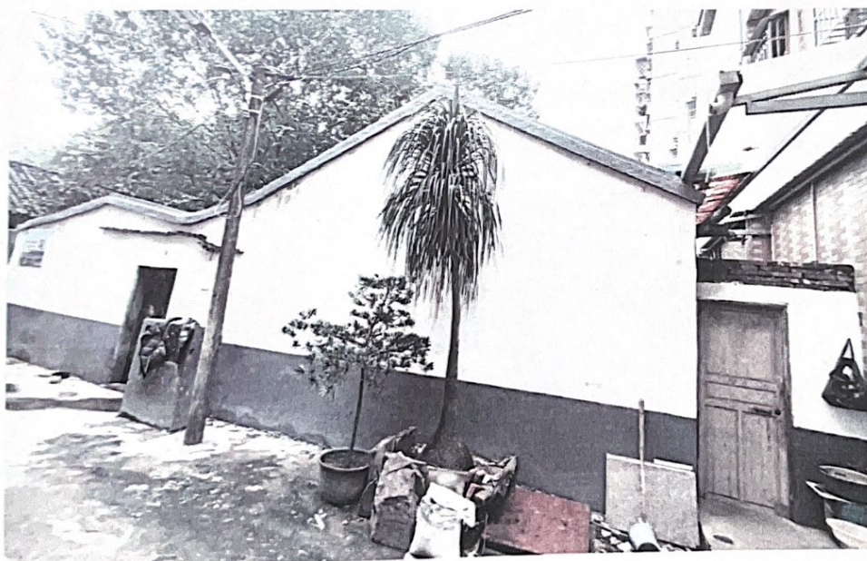
照片 1 房屋外立面
