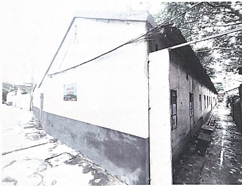
照片 1 房屋外立面
