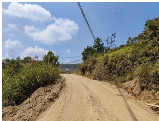
照片 16 矿区道路（镜头朝正南）
