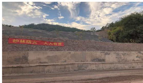
照片 8 治理后挡土墙
