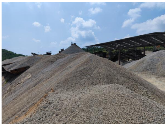
照片 13 工业场地 1（镜头朝西北）
