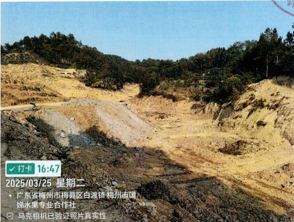
图 4 L2 弃土场现场照片
