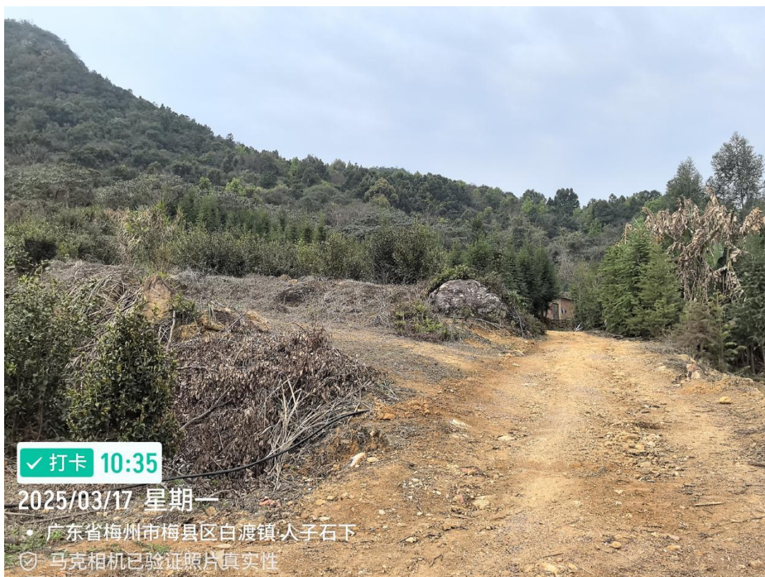
图 3-4 临时用地实地照片（高岭斜井施工便道）
