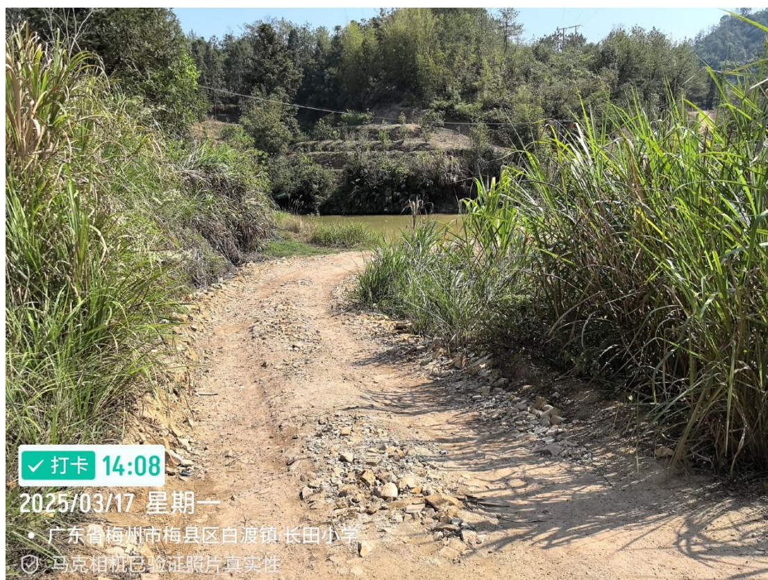
图 3-6 临时用地实地照片（长田 2 号施工便道）
