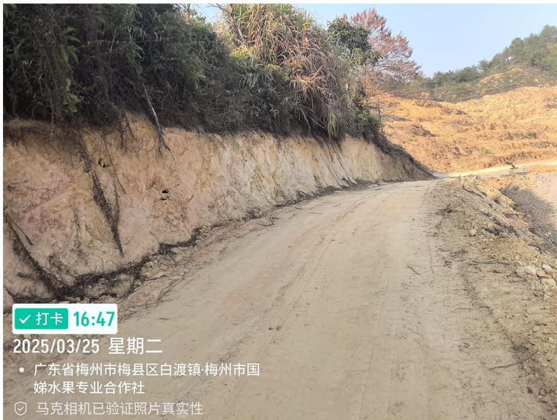
图 3-6 L2 施工便道实地照片
