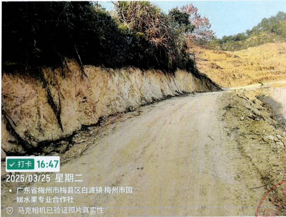
图 3 L2 施工便道现场照片
