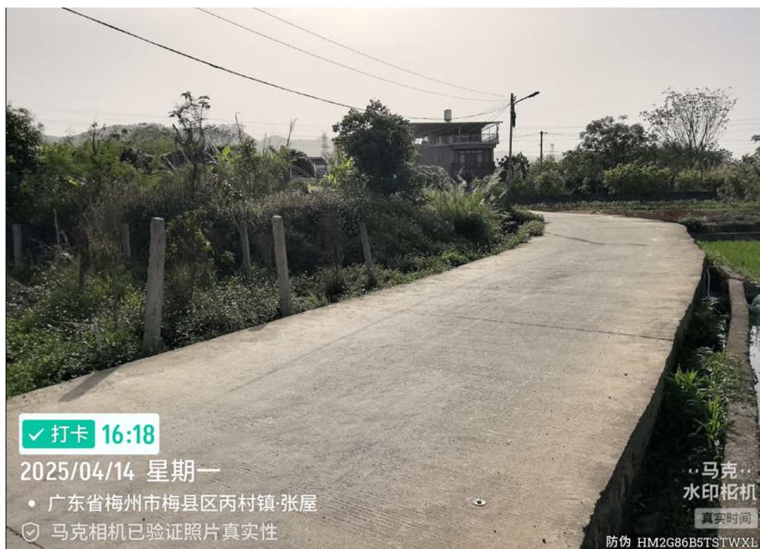
图 3-8 雁洋西跨漳龙 27-41 号墩便道实地照片
