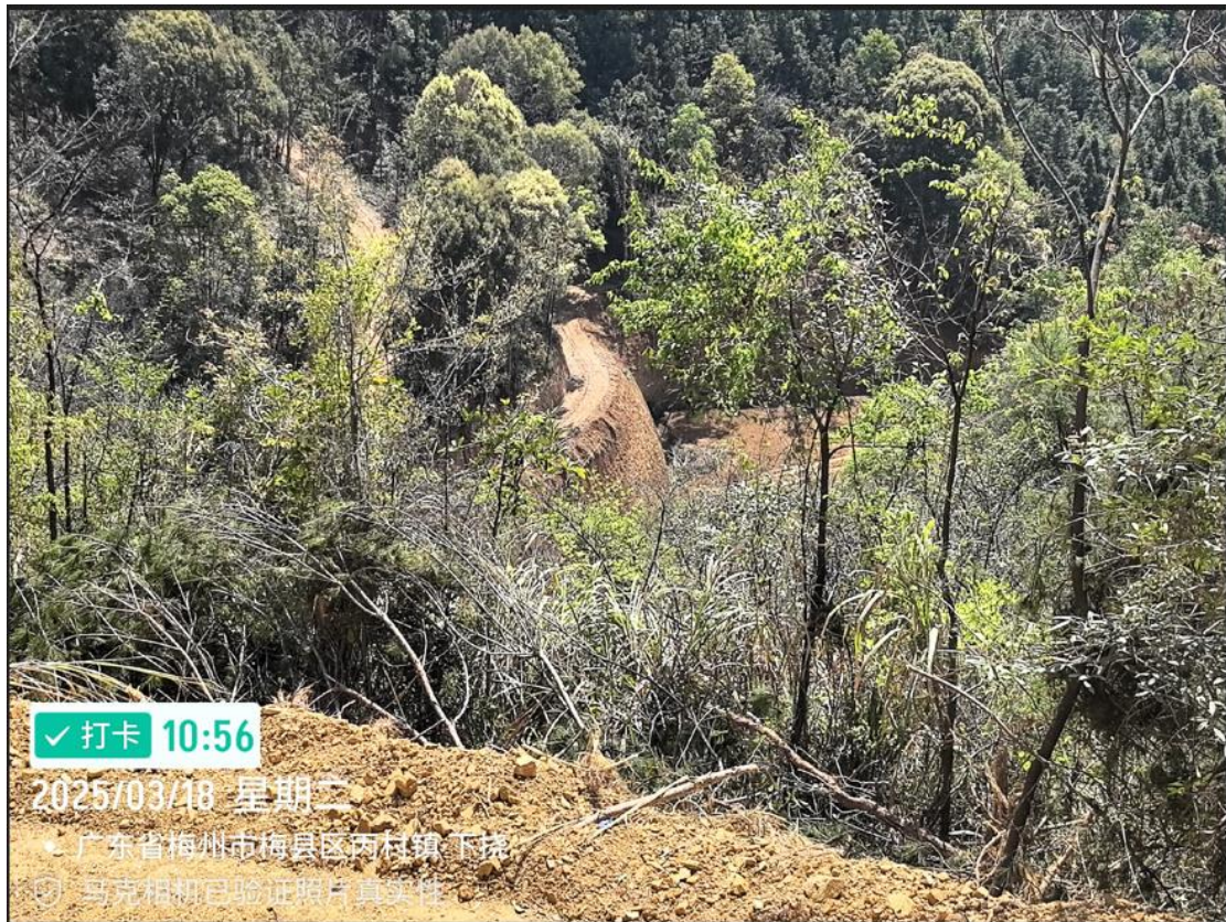
图 3-12 寨背山出口施工便道实地照片
