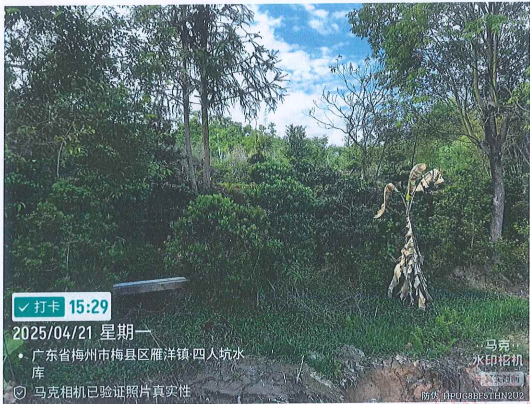
图3 永福特大桥架梁通道施工便道现场照片-1
