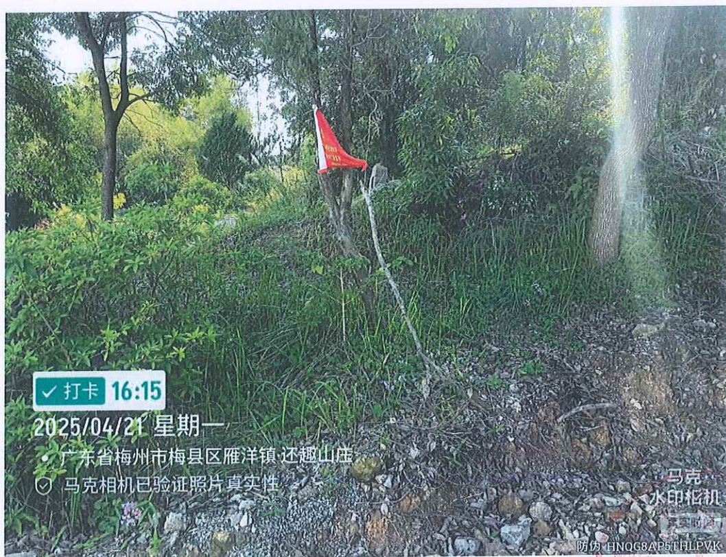
图 7 文社隧道出口施工便道照片-2
