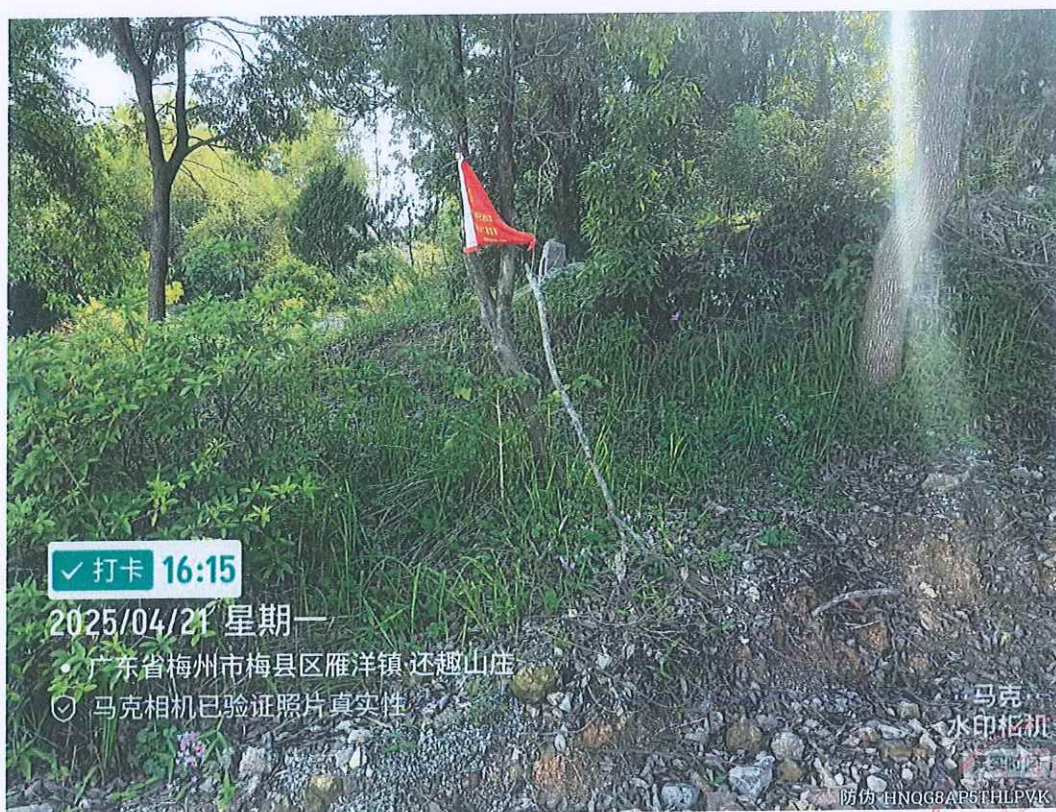
图 7 文社隧道出口施工便道照片-2
