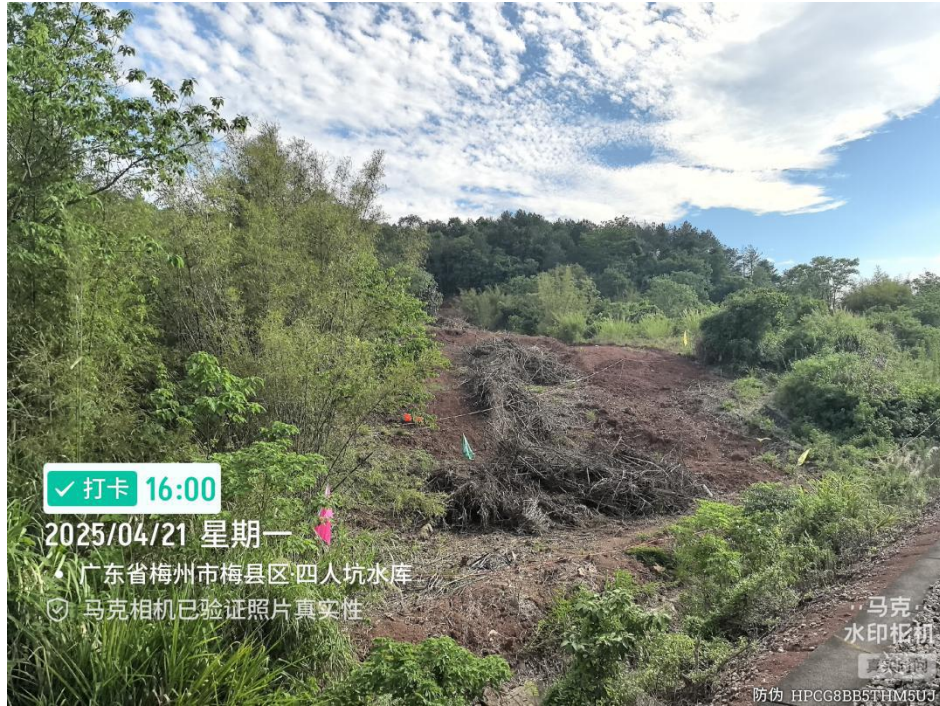
图 3-5 临时用地实地照片（文社进口通所施工便道）
