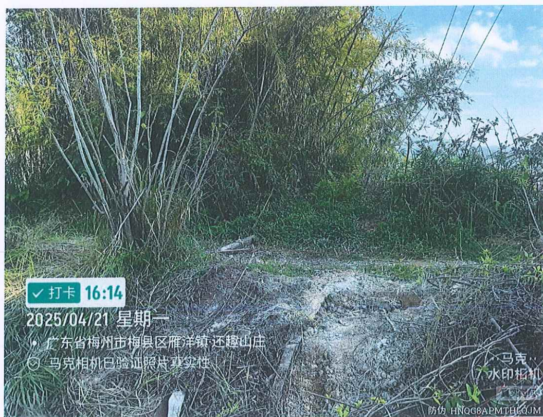
图6 文社隧道出口施工便道照片-1
