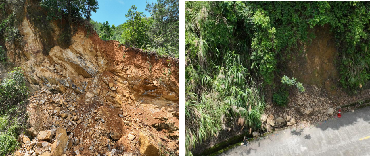
K20+069～K20+139 段左侧边坡松石剥落、边沟损毁
