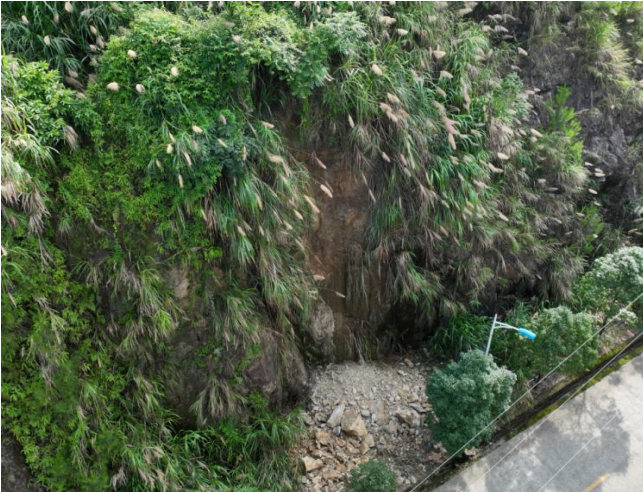
K26+115~K26+135段长度约20米路基右侧上边坡松石剥落、冲刷
