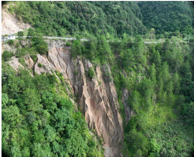
K25+300~K25+505 段路基左侧下边坡滑塌及边沟损坏；右侧上边坡滑塌
