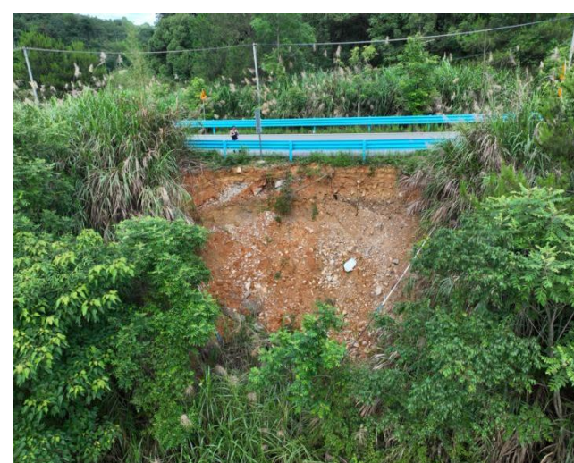
K33+750~K33+780 段长度为 40 米路基右侧下边坡塌陷及路侧波形护栏损坏
