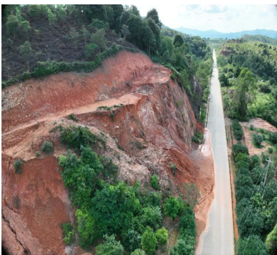
K26+540~K26+660 段路基右侧上边坡滑塌、冲刷及边沟损坏
