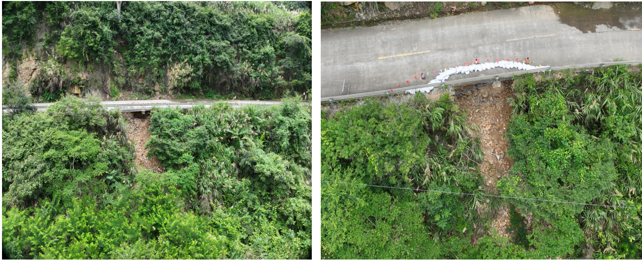
K19+006～K19+016 段路基右侧下边坡塌陷及路侧波形护栏损坏
