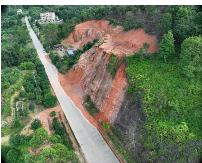
K26+540~K26+660 段路基右侧上边坡滑塌、冲刷及边沟损坏
