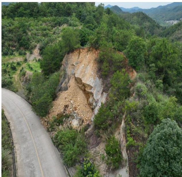
K23+590~K23+760 段边坡松石剥落、冲刷
