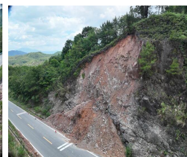
K35+050~K35+100 段路基右侧上边坡滑塌及边沟损坏
