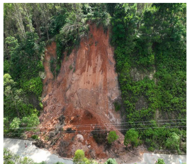
K29+935~K29+985 段路基右侧上边坡滑塌
