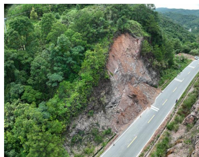
K35+050~K35+100 段路基右侧上边坡滑塌及边沟损坏
