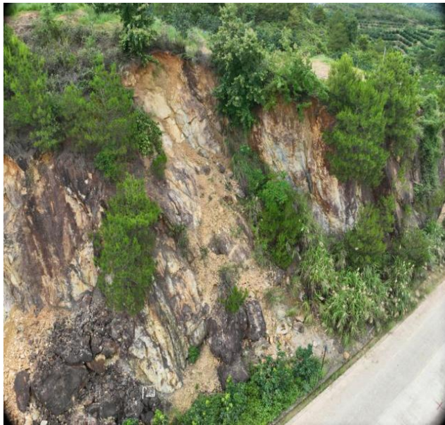
K23+590~K23+760 段边坡松石剥落、冲刷
