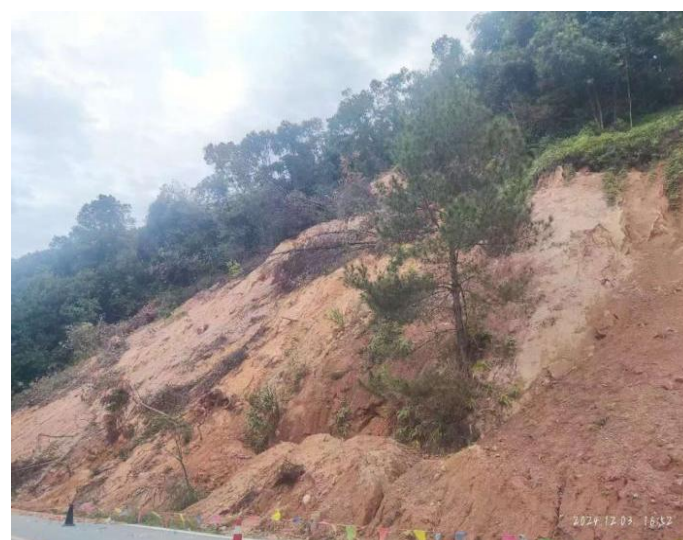
K34+250~K34+430 段路基左侧上边坡塌陷
