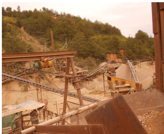
照片 7 工业场地 (镜向 NE)
