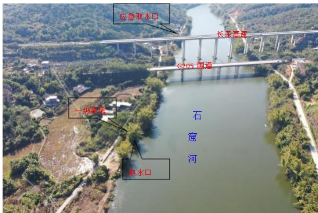
图 4-5 梅州城区供水保障工程--梅县区产业集聚地供水扩容工程
