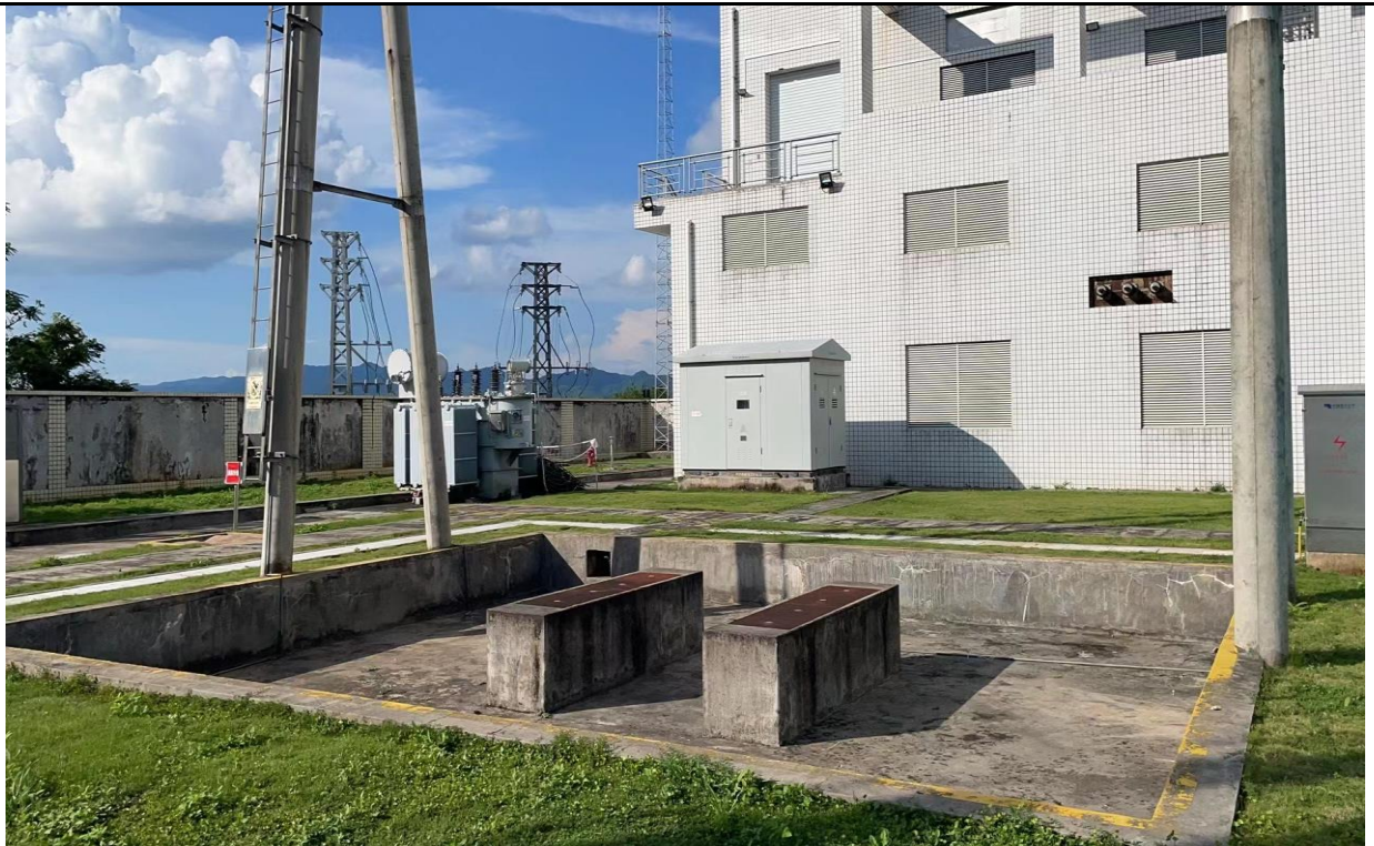
图 2.3 预留 2#主变建设场地（储油坑、构架及横梁前期已完成）
