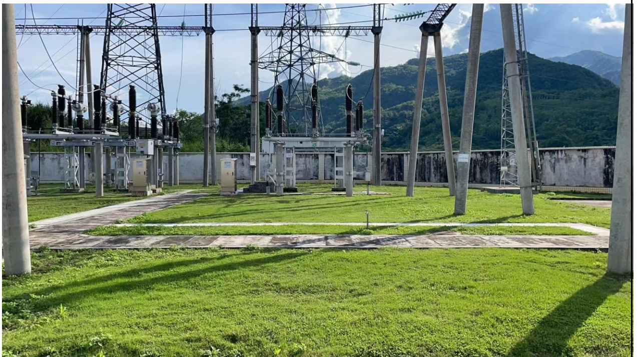
图 2.4 预留 2#主变进线间隔场地
