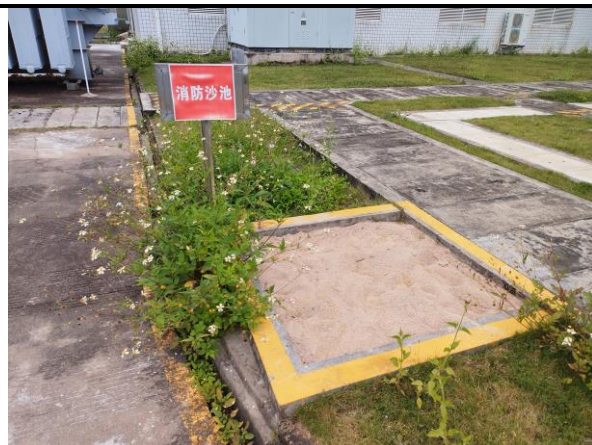
站内消防设施
