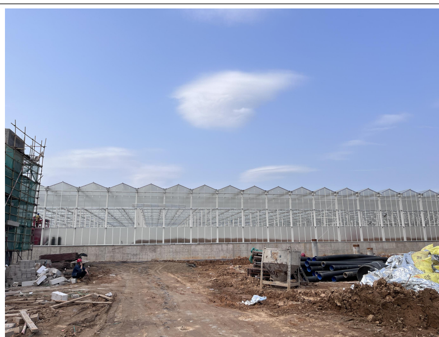
项目北面（在建大棚）
