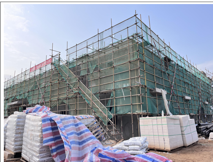
项目西面（在建附属设施）
