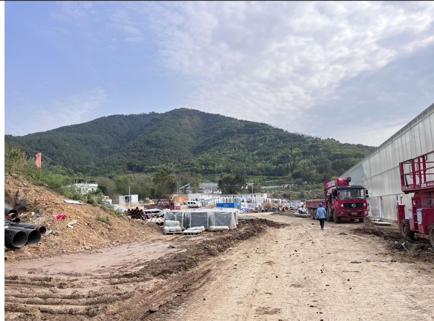
项目南面（在建大棚）
