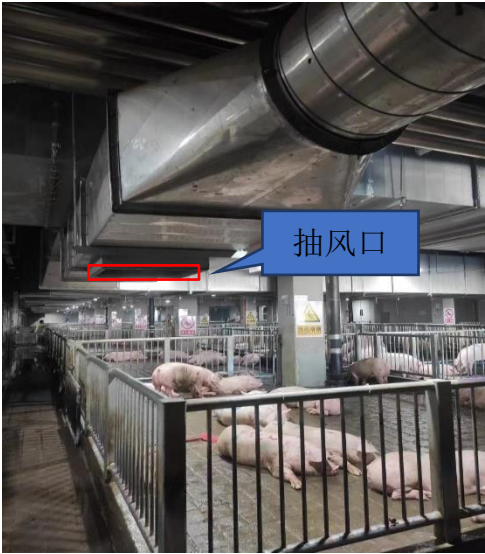
图3.7-2 待宰车间抽风装置示意图
