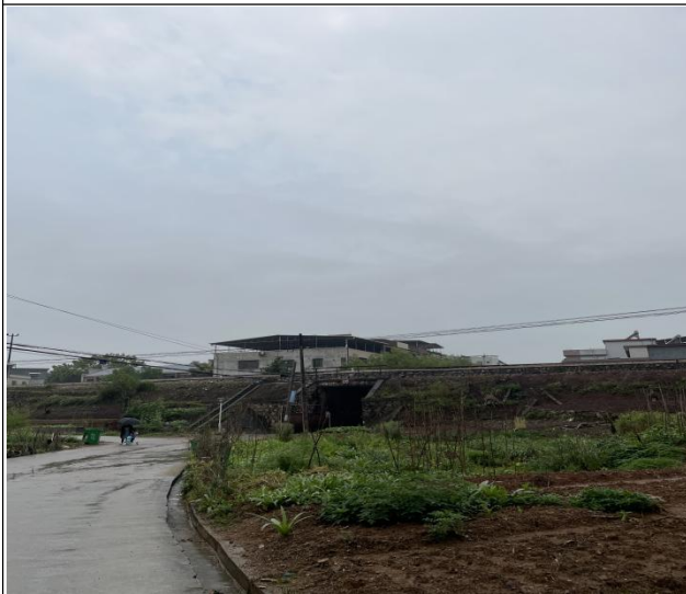
下穿漳龙线铁路涵洞
